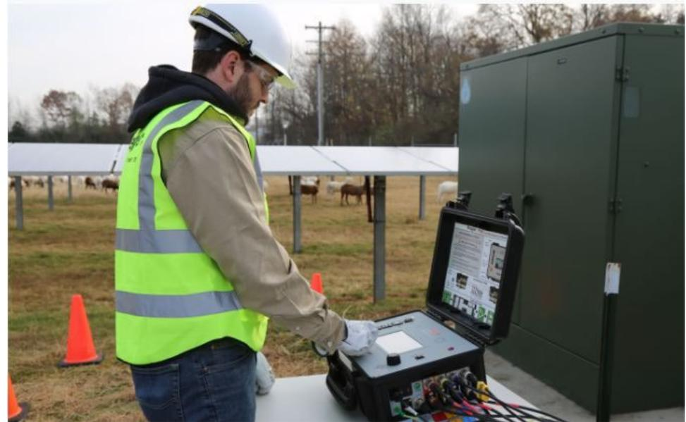
Fig. 2 Pruebas de mantenimiento a transformadores de instrumentos.
