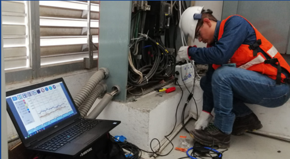
Fig. 1 Instalación de medidor en tablero de distribución.
