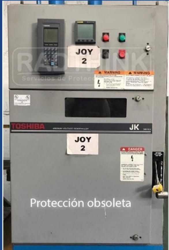
Fig. 1 Relevador de protección original obsoleto.
